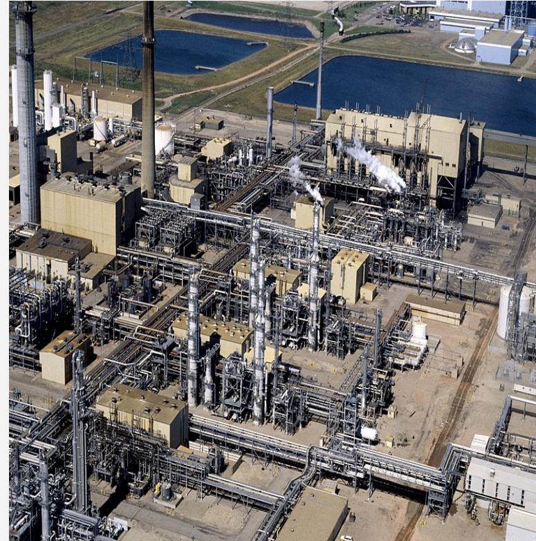
Capture pré-combustion de CO 2 sur une usine de gazéification du charbon dans le Dakota du Nord aux USA (3.3 MtCO 2 / an).
